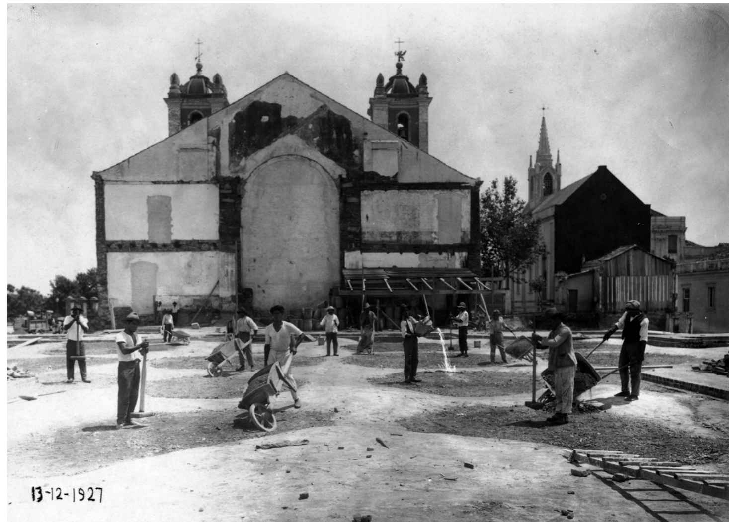
▼ Foto 69. [13/12/1927] No mês de novembro realizou-se a concretagem do forro e entrepiso da cripta, na qual o concreto da betoneira era derramado com carrinhos, espalhado e adensado manualmente com pilões. O canteiro de obra efervescia com a atividade e, em dezembro, os operários preenchiam com brita os vazios deixados pelas formas das abóbadas do forro.
