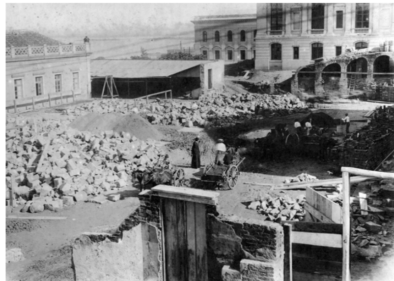
◀ DA ESQ. PARA DIR.: Foto 42. Em primeiro plano, a fundação de um dos pilares já concluída; em segundo plano, a fundação de outro pilar em execução.
