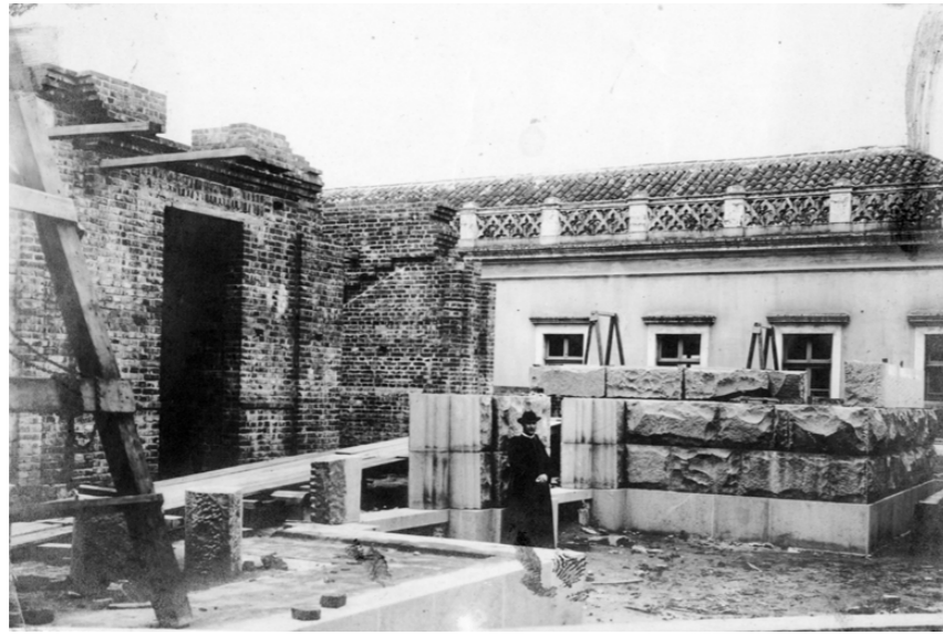
► Foto 50. [1923] Segunda fiada de pedra granítica instalada.
