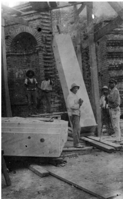
◀ Fotos 54 e 55. Colocação ▼ das pilastras de grani- to no interior da cripta (rua Dom Sebastião).
