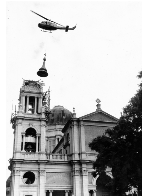
▲ Fotos 106, 107, 108 e 109. [14/03/1970] Inauguração da torre, lado da rua Espírito Santo, com a colocação do lanternim. O trabalho teve início no pátio do Instituto Parobé.
