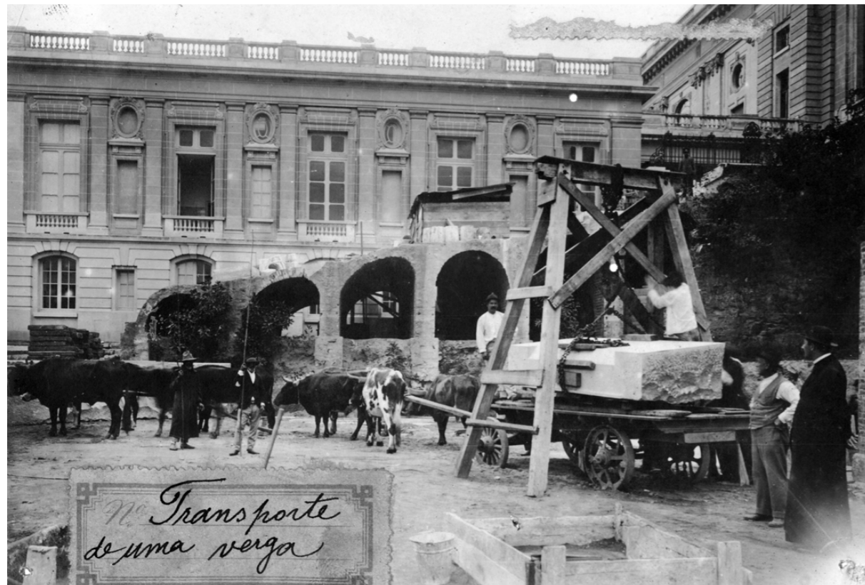
▲ Foto 33. Içamento do bloco de granito pela talha-patente, enquanto os bois que puxavam o carretão aguardam, com seus guias ao lado. À direita, Mons. Balem e José Brunelli; de pé, e de frente para a foto, Luiz Marques, pedreiro português.
