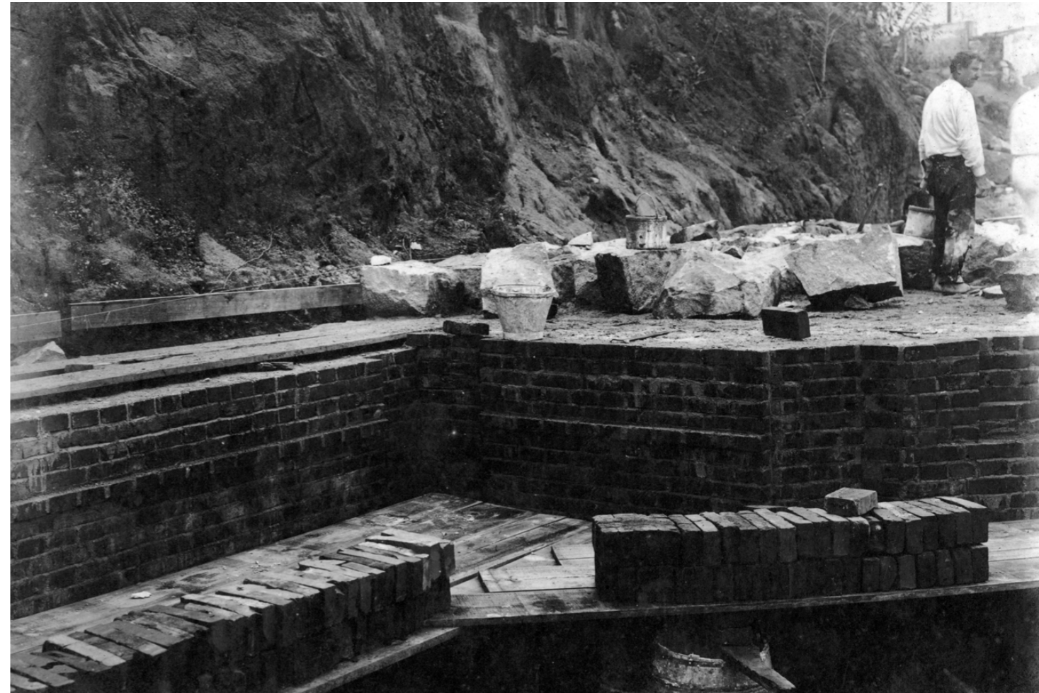
◀ Fotos 48 e 49. Enquanto sobe o arrimo de pedra, as paredes e pilares de alvenaria da cripta são elevados.
