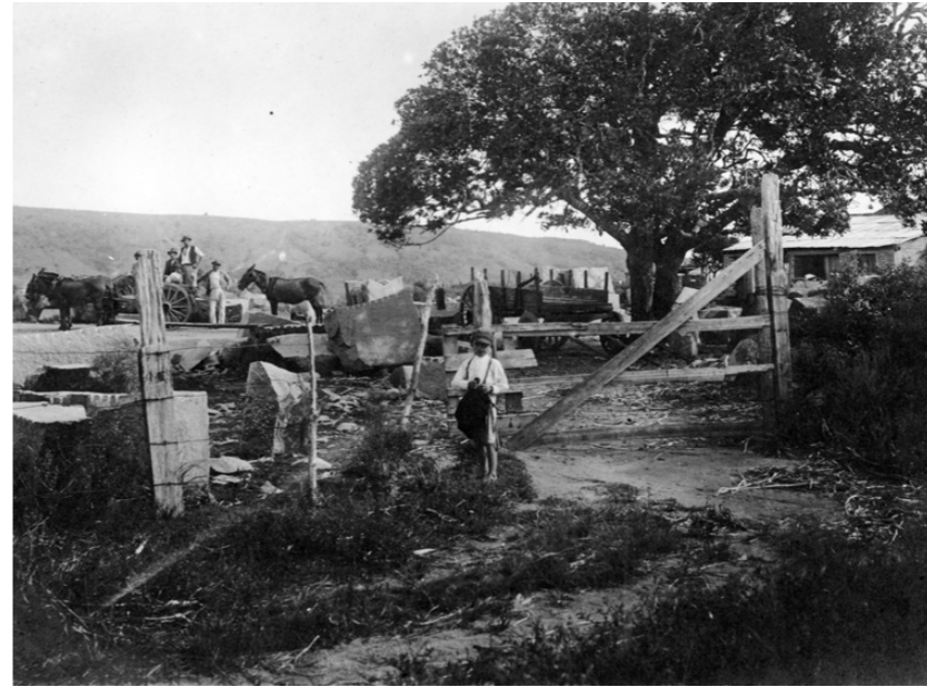
◀ Foto 23. Tragédia em Teresópolis: Mons. Balem registrou que, aos 23 de dezembro de 1934, os meninos Arnaldo Freitas (10 anos) e Adroaldo Rossata (6 anos) afogaram-se em uma das escavações da pedreira que estava cheia d'água.
