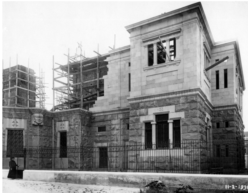
▲ Foto 77. Construção das sacristias e interior da nave. Entre os andaimes, os pilares que sustentarão a grande cúpula.
