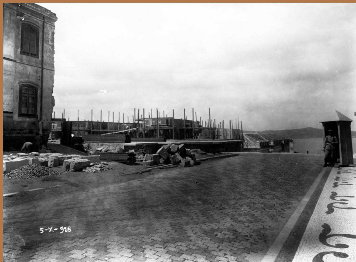
▲ Foto 63. Em uma cidade sem torres de edifícios, do alto da matriz, o lago Guaíba com a enseada de Belas, posteriormente aterrada, era avistado no horizonte. As obras seguiam lentamente, sobre a cripta concluída subiam os pilares da cúpula, em alvenaria de tijolos e concreto.
