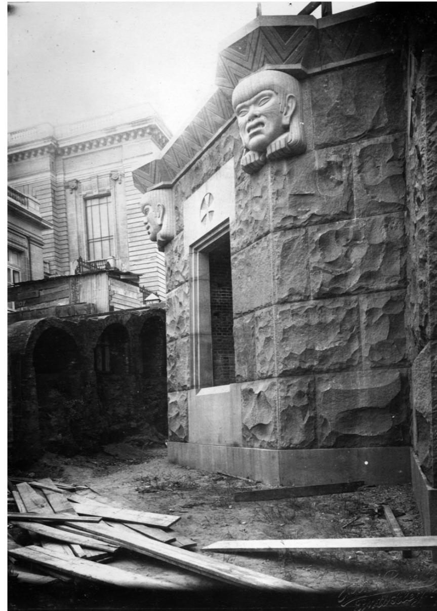
▲ Foto 12. À esquerda na imagem, um dos arcos que estruturavam as rampas escalonadas da rua Dom Sebastião.
