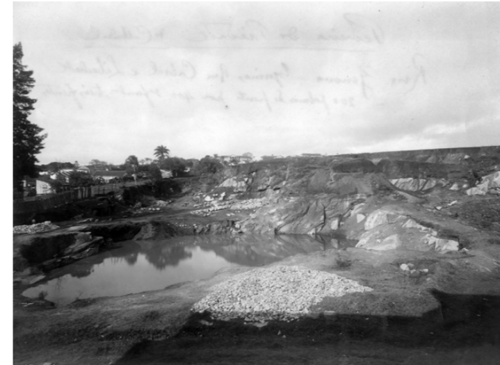
◀ Foto 16. Pedreira da Piedade, situada entre as ruas Cabral e Vasco da Gama.
