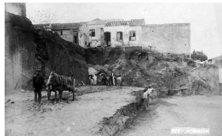
▲ Foto 40. [ca. 1921] Terreno já recortado e parcialmente aplainado. Ali os operários trabalhavam na remoção de um patamar de terra. Ao fundo, casas de meia morada, exemplares da arquitetura luso-açoriana do século XVIII.
