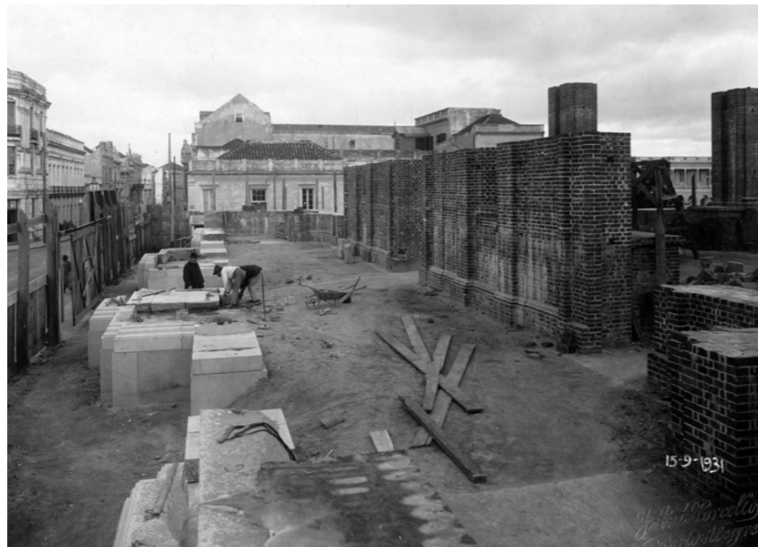
► Foto 79. Construção do pódio que eleva o átrio em relação à rua Duque de Caxias. Na parte direita, as paredes de alvenaria que dividem o átrio da nave. Sob supervisão do Mons. Balem, pedreiros assentam pedras que servirão de base para as colunas monolíticas e formarão o pórtico principal de acesso.
