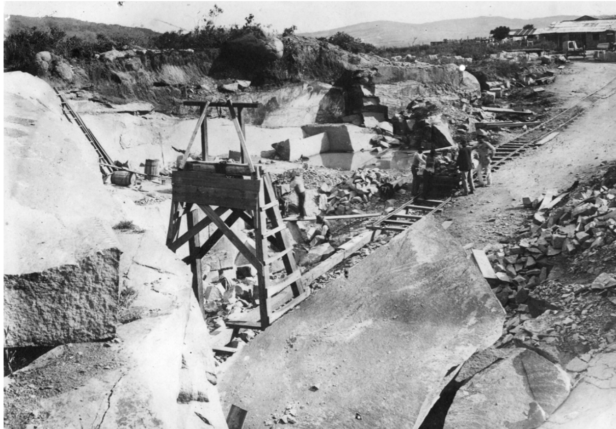
▲ Foto 22. Após verificar a dificuldade do transporte dos grandes blocos de granito, Mons. Balem procurou, em 1925, a Viação Férrea do Rio Grande do Sul (VFRGS) e solicitou o empréstimo de 20 trilhos para poder levar o granito desde a pedreira até o canteiro da cantaria. Assim, os blocos passaram a ser levantados por uma talha-patente instalada em um cavalete móvel de madeira. Depois de erguidos, eram colocados sobre o carrinho puxado por um guincho sobre trilhos. Dessa forma, eram transportados com toda a regularidade para o telheiro da cantaria, onde eram preparados.
