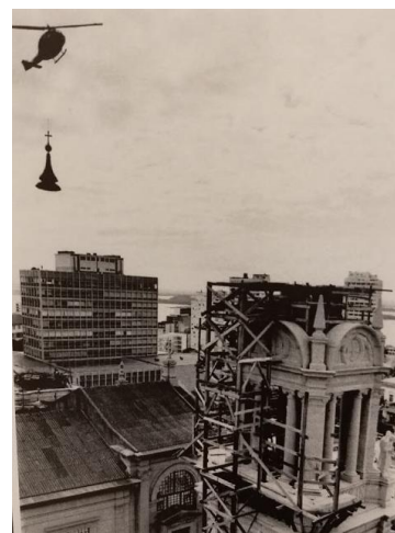
Figura 21. Construção do transepto e armação do tambor da cúpula por volta de 1934. AHCMPPA, Porto Alegre.
