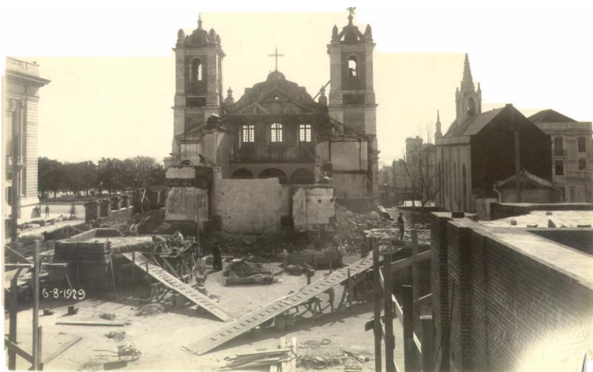
Figura 15. Início da construção do presbitério e nave e demolição total da antiga catedral por volta de 1929. AHCMPA, Porto Alegre.
