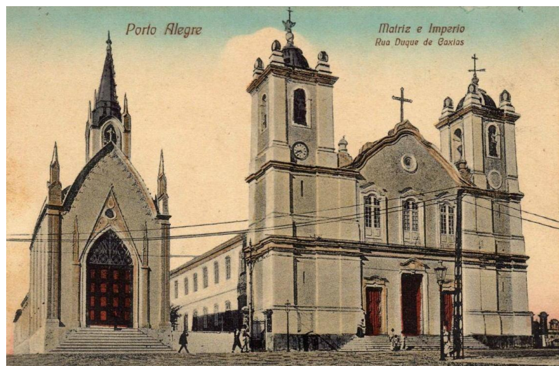
Figura 3. Antiga catedral e Império por volta de 1900. Edificações que seriam demolidas para a construção da nova catedral. AHCMPA, Porto Alegre
